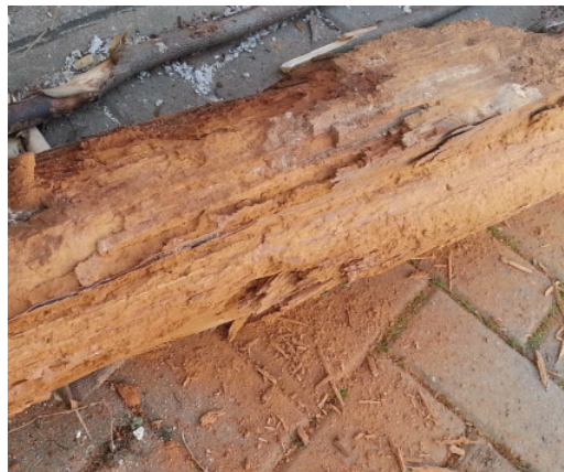
Tragender Deckenbalken aus dem Hertleinshaus
